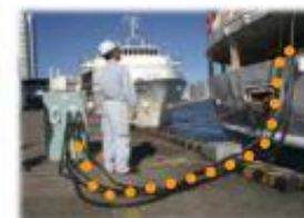
電力供給設備
