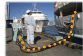
電力供給設備
