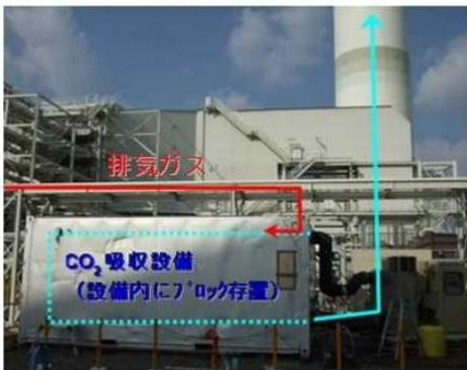
炭酸化養生設備
