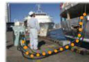
電力供給設備
