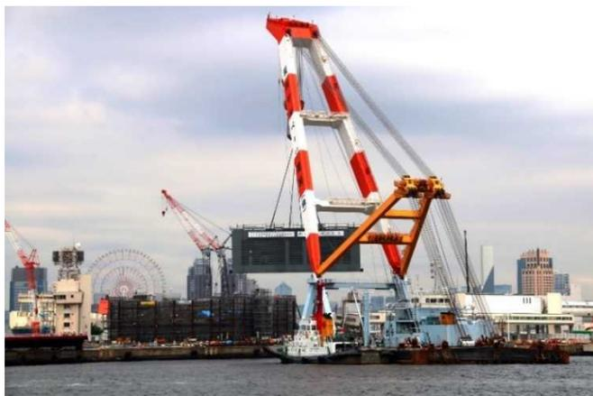
(上) 南北線端部鋼殻一括架設 (下) 沈埋函の水中仮置き【東京港湾事務所】
