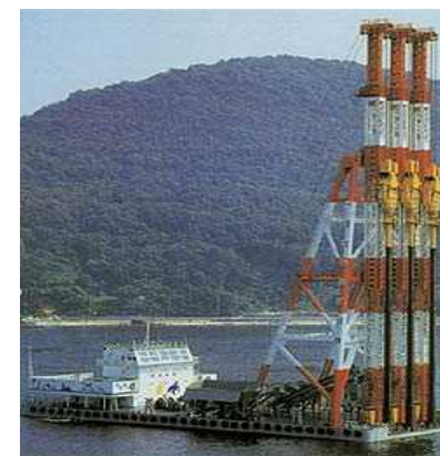
SCP船(地盤改良)
