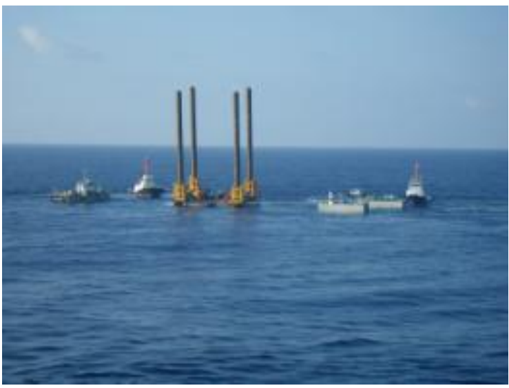
シンキングバージに注水し中央棧橋を浮上
