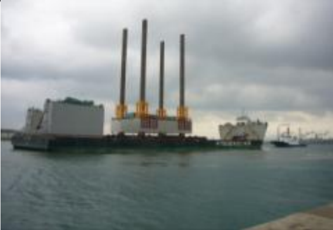
シンキングバージで運搬中の中央棧橋
