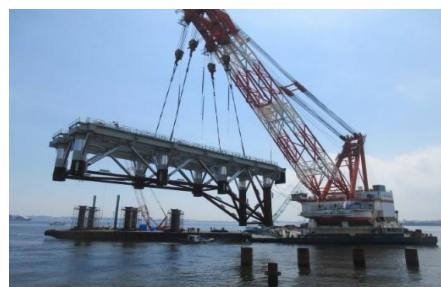
ジャケット据付状況
