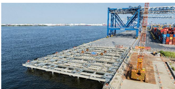
令和5年度 東京港中央防波堤外側地区 岸壁(－16m)(耐震)築造工事 完成
