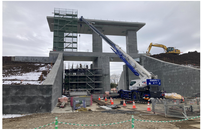
写真 水門整備施工状況 (茨城県常陸大宮市)
