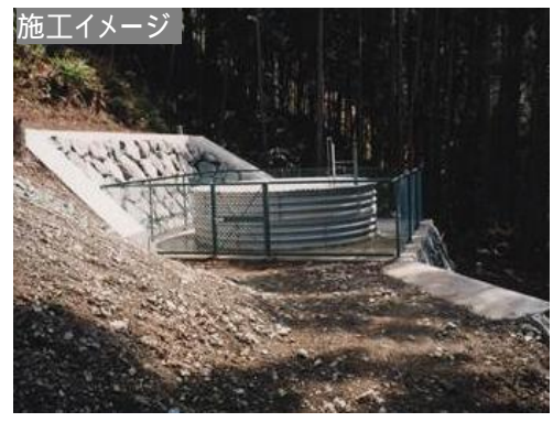
抑止工(集水井)
