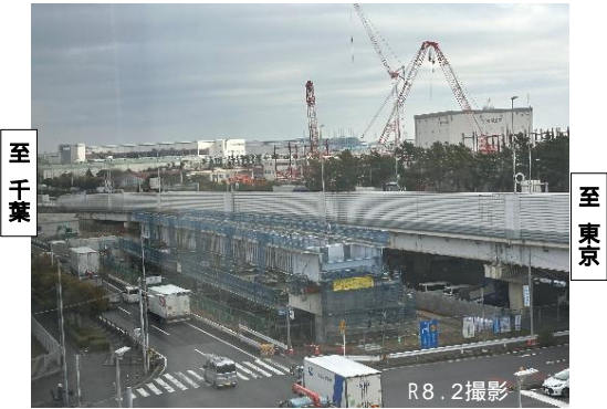
至千葉 至東京 しおはま 写真 : 塩浜立体区間の施工状況 R8.2撮影
