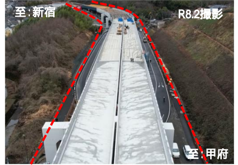
工事状況(寺田地区)
