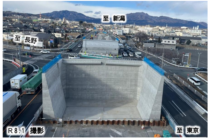
橋梁下部工事の施工状況
