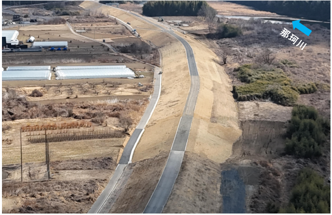
写真 堤防整備施工状況 (茨城県大宮市)
