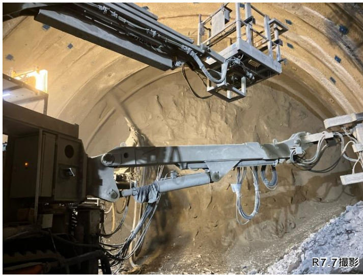
トンネル工事施工状況
