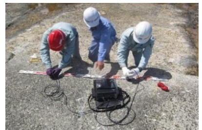
コンクリート護岸ひび割れ補修・点検
