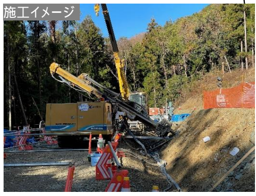
抑止工(アンカー工)
