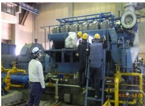
老朽化した主原動機(ディーゼルエンジン)を改良更新
