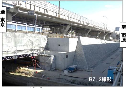
写真②: 末広橋の拡幅工事の施工状況
