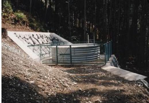
抑止工(集水井)施工イメージ
