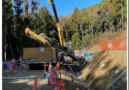
抑止工(アンカー工)施工イメージ
