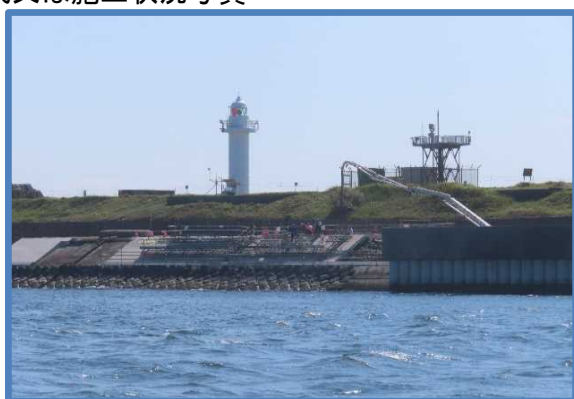
上部工施工状況
