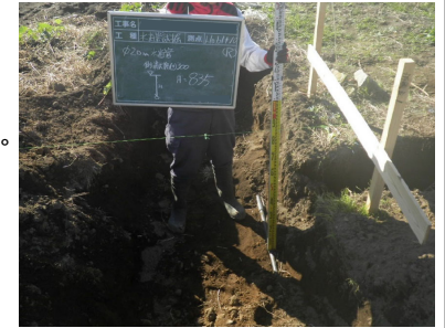
【試掘による確認】
