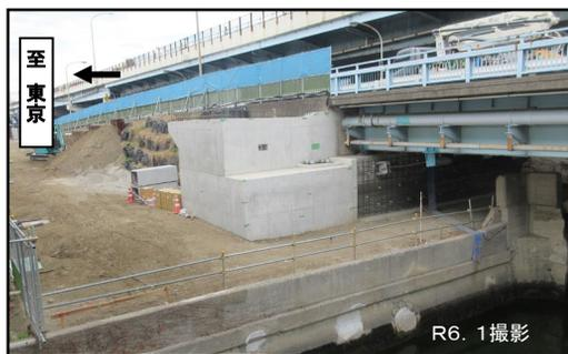
写真②: 末広橋の拡幅工事の施工状況
