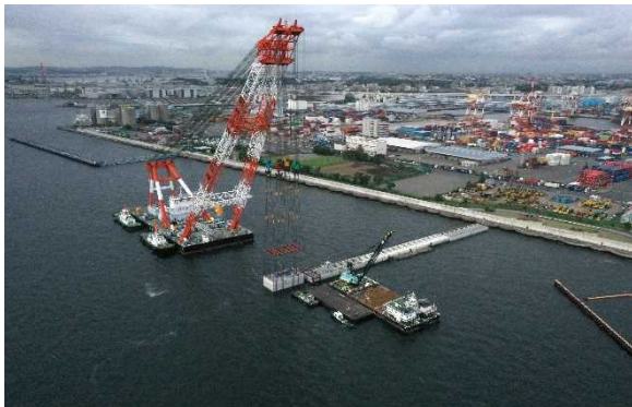
ケーソン据付施工状況
