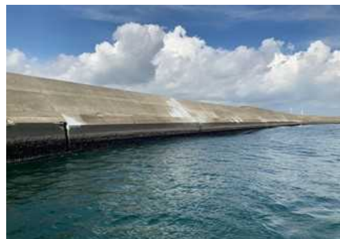
補修完了状況
