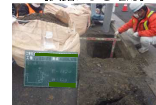
【試掘による確認】
