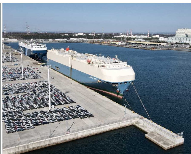
D岸壁 延長300m運用状況
