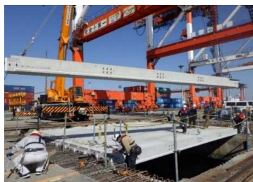
復旧工(PC木口一桁据付)
