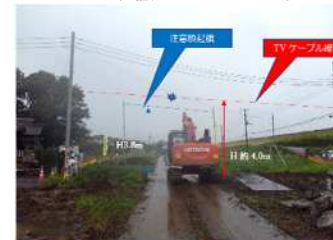
バックホウのアームを上げたまま走行したことにより架空線を損傷した事故の写真
