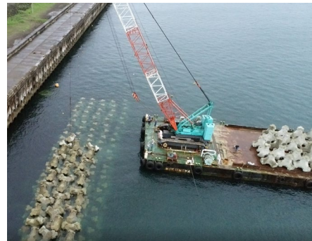
消波ブロック据付状況
