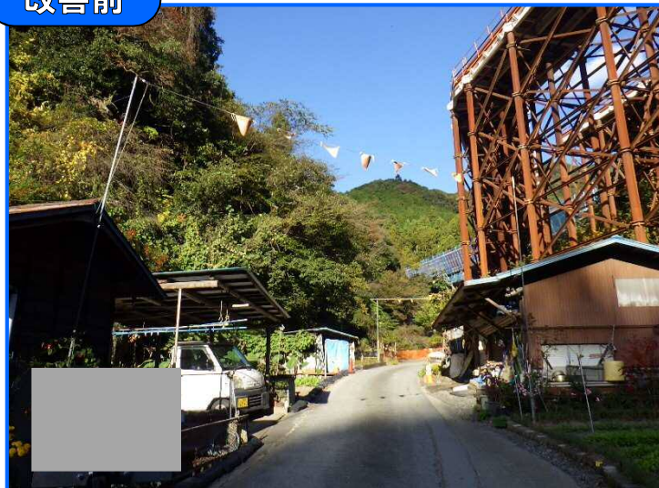
架空線明示旗の劣化
