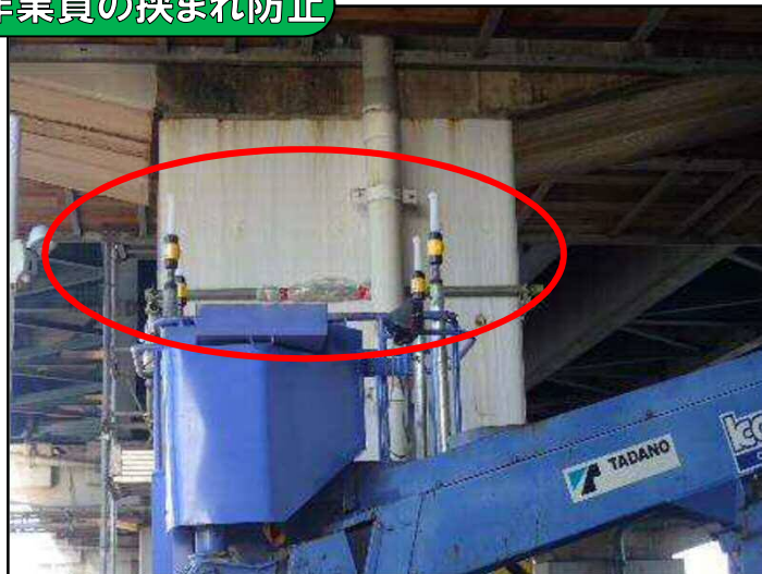
高所作業車の挟まれ防止対策
