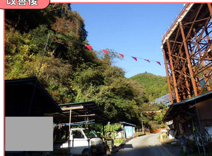
架空線明示旗を交換
