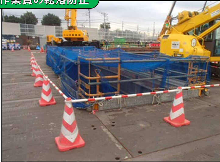
作業開口未使用部分に転落防止ネット
