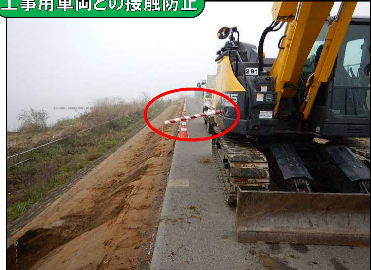
重機接触防止装置の使用
