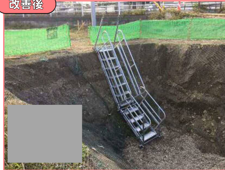
手すり付きの昇降設備を設置
