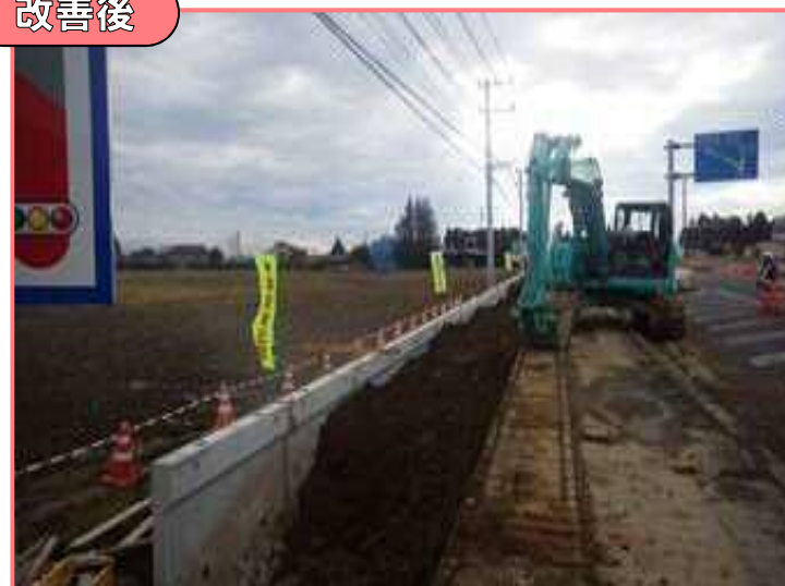
作業箇所に応じて移動・設置
