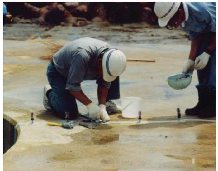
コンクリート護岸ひび割れ補修
