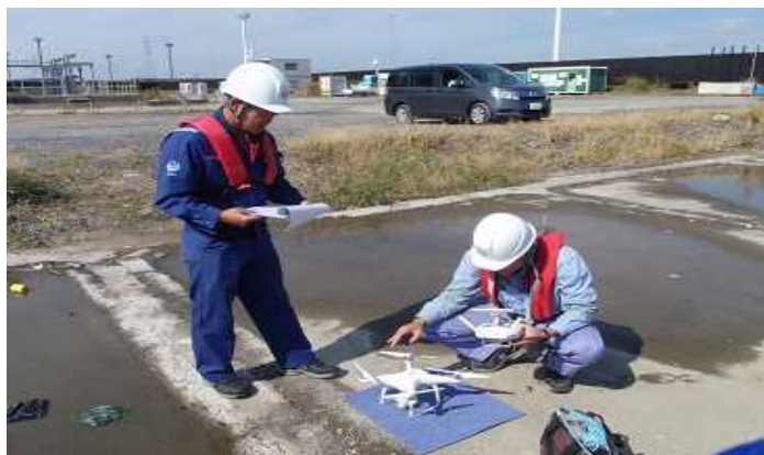
茨城港常陸那珂港区点検状況①
