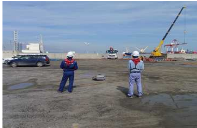
茨城港常陸那珂港区点検状況②
