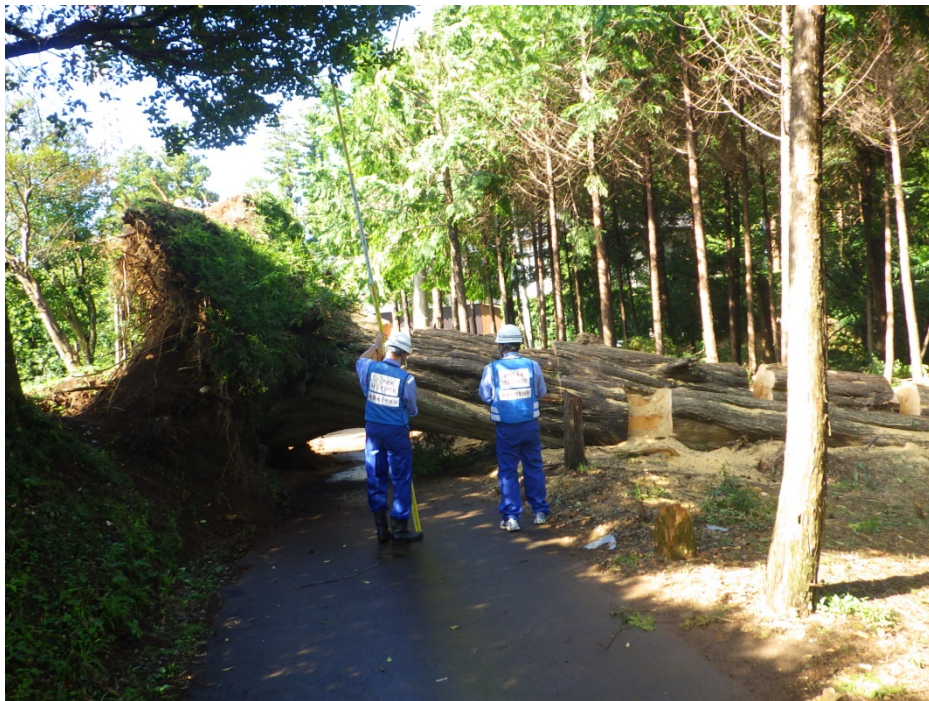
【香取市：市道における倒木除去を実施(作業前)】
