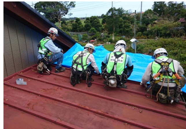
【山武市:ブルーシート設置状況】
