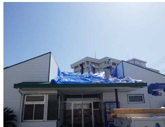
【ブルーシート設置状況】
