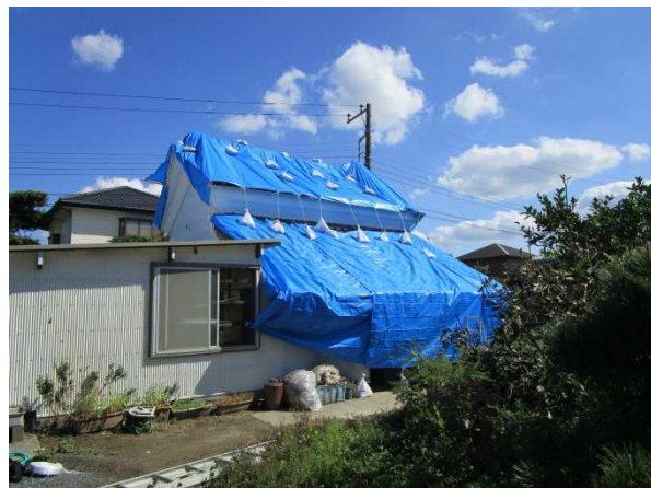
【ブルーシート設置状況】
