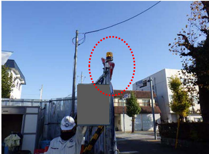
現場出入り口部に工事関係車両の出入りを報 せる警告ランプを設置
