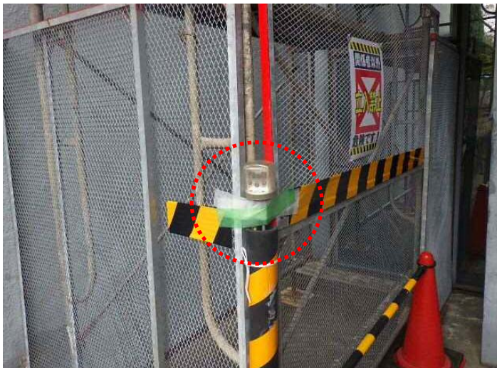
足場の角部にLEDライトを設置し接触を防止
