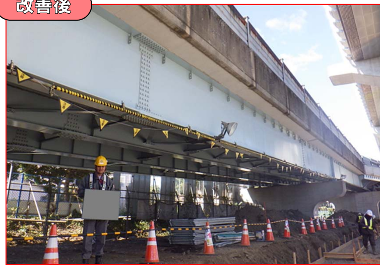
三角旗を設置し、近接注意箇所を明示
