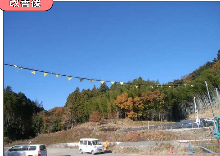
三角旗を全面的に設置し、架空線の視認性を向上
