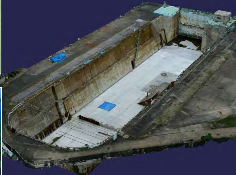
↑ ドローン空中測量による現在の京浜港ドックの3DCG
