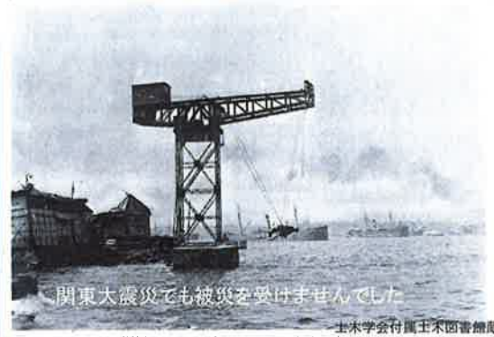
横浜港 震災に無事なる50噸定置式起重機
