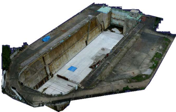
京浜港ドック（土木学会選奨遺産）
