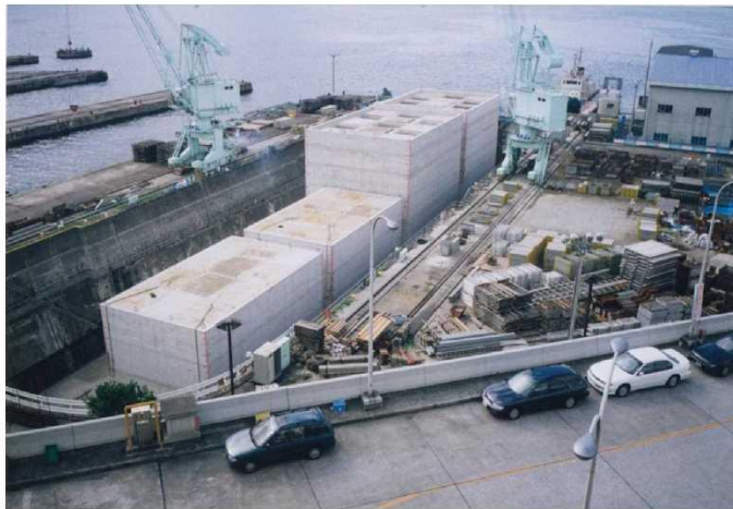
平成10年代のケーソン製作状況
