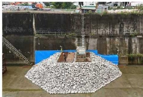
写真-2 ドック内の実大規模捨石マウンド
