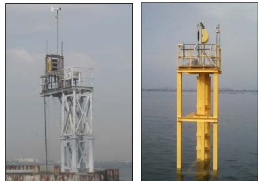
設置されたモニタリングポスト (川崎人工島) (浦安沖)
