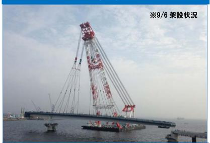
事前に施エヤード(袖ヶ浦)で組立した橋桁ブロック(大ブロック③: L=約 120m, 高さ約6m, 最大幅 15.5m, 重さ約 1,460t)を台船で架設位置(南本牧)まで運搬し、大型起重機船(3000t 吊)を用いて架設を行います。
