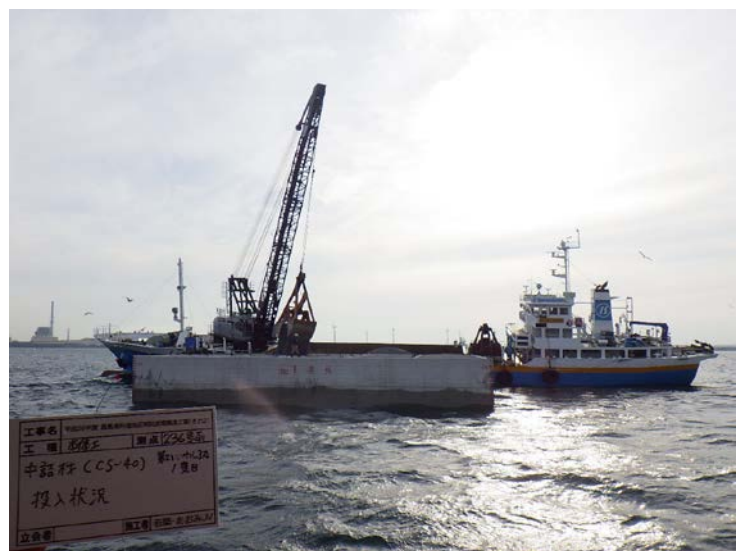
中詰材投入状況
