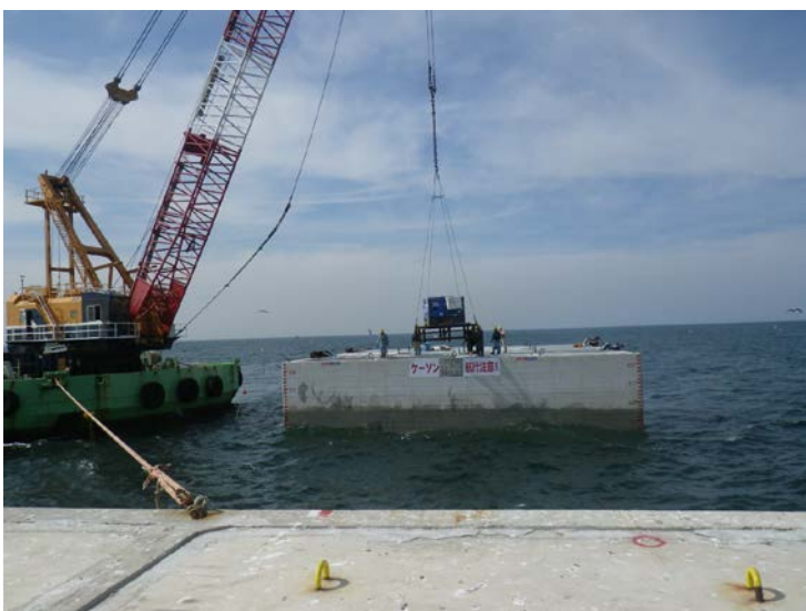
艀装材撤去状況
