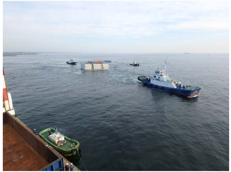
据付位置引き込み状況
