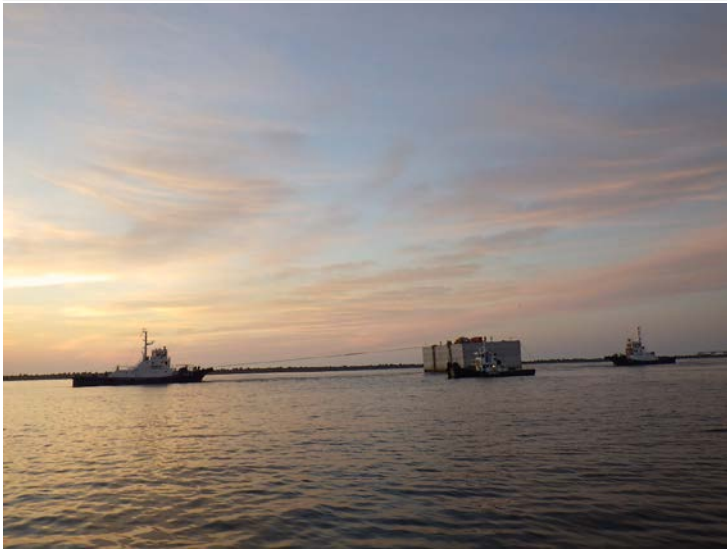
ケーソン曳航状況
