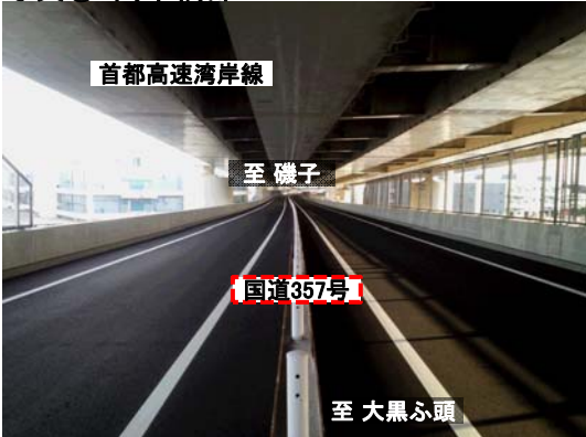
写真③: 高架橋部
