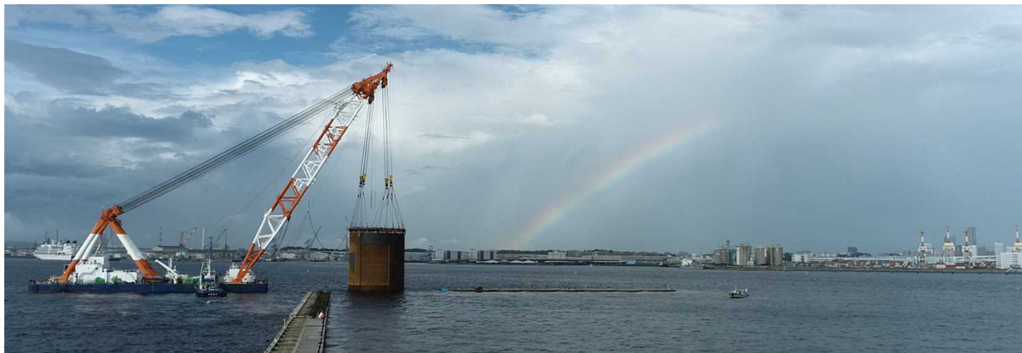
横浜港新本牧地区岸壁(-18m) 鋼板セル据付
