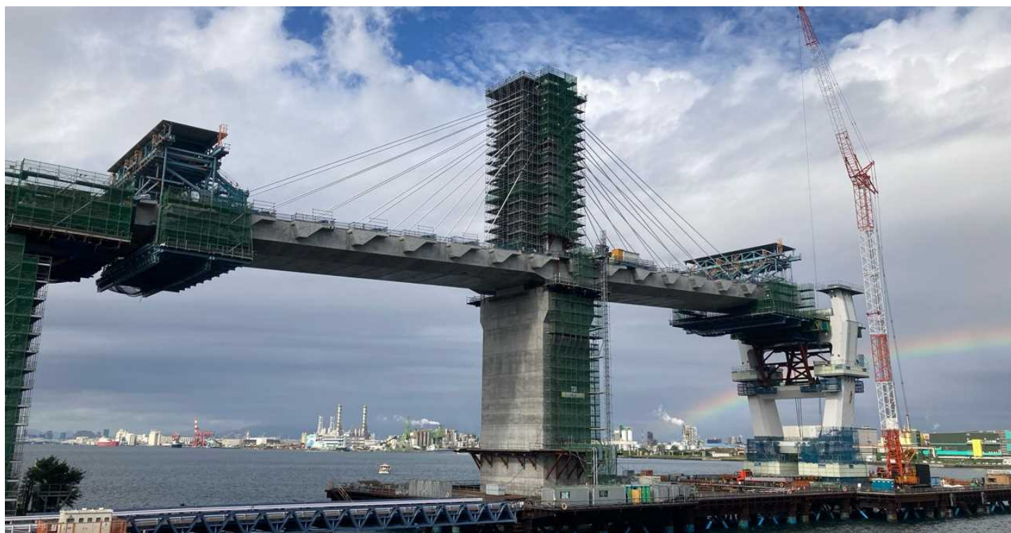
川崎港東扇島～水江町地区臨港道路 東扇島側側径間全景
