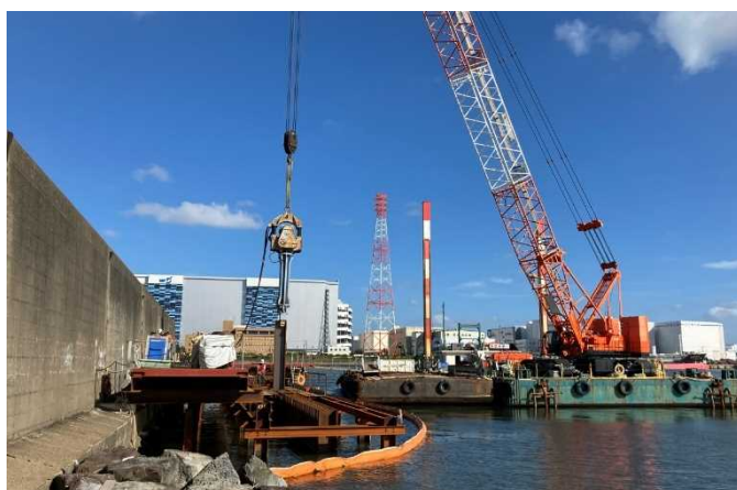
千葉港海岸船橋地区日の出護岸 高剛性壁体打設
