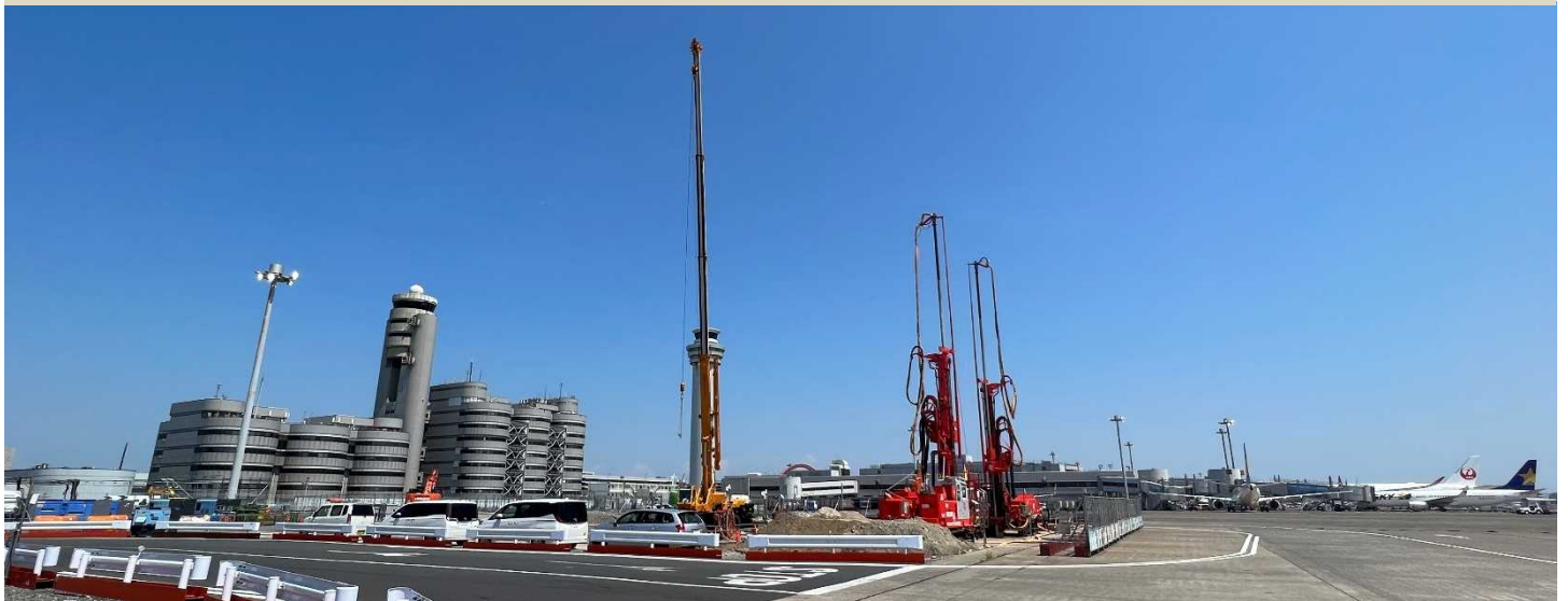
東京国際空港西側貨物地区エプロン 地盤改良
