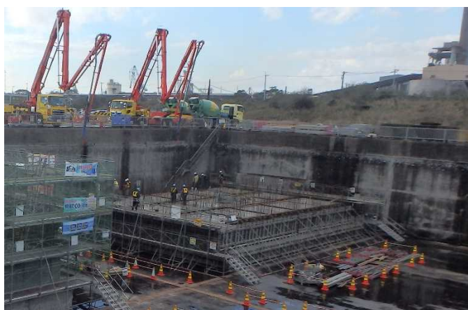
鹿島港外港地区中央防波堤 ケーソン製作コンクリート打設 (ドライドック)
