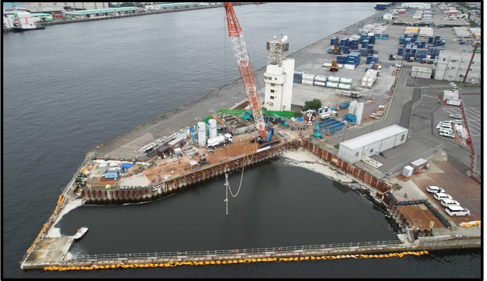
東京港10号地その2地区岸壁(-7.5m) SGM(軽量混合処理土)打設【裏埋工】
