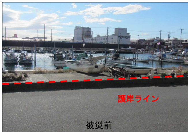
令和元年台風第15号による被害
