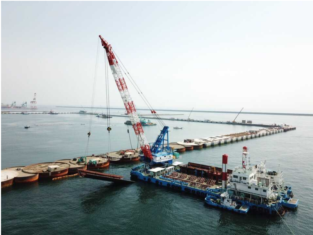
茨城港常陸那珂港区廃棄物護岸アーク設置【鹿島港湾・空港整備事務所】
