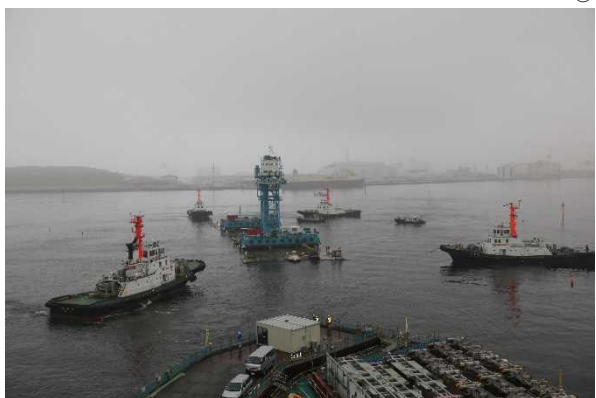
① 鹿島港南防波堤ケーソン引出・曳航 ④ 東京空港A滑走路アスファルト舗装
