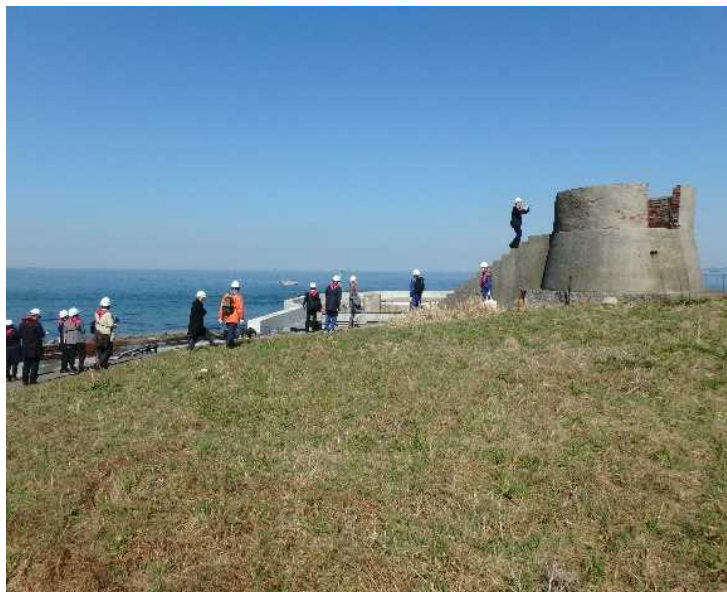
第二海堡インフラツーリズム【東京湾口航路事務所】
