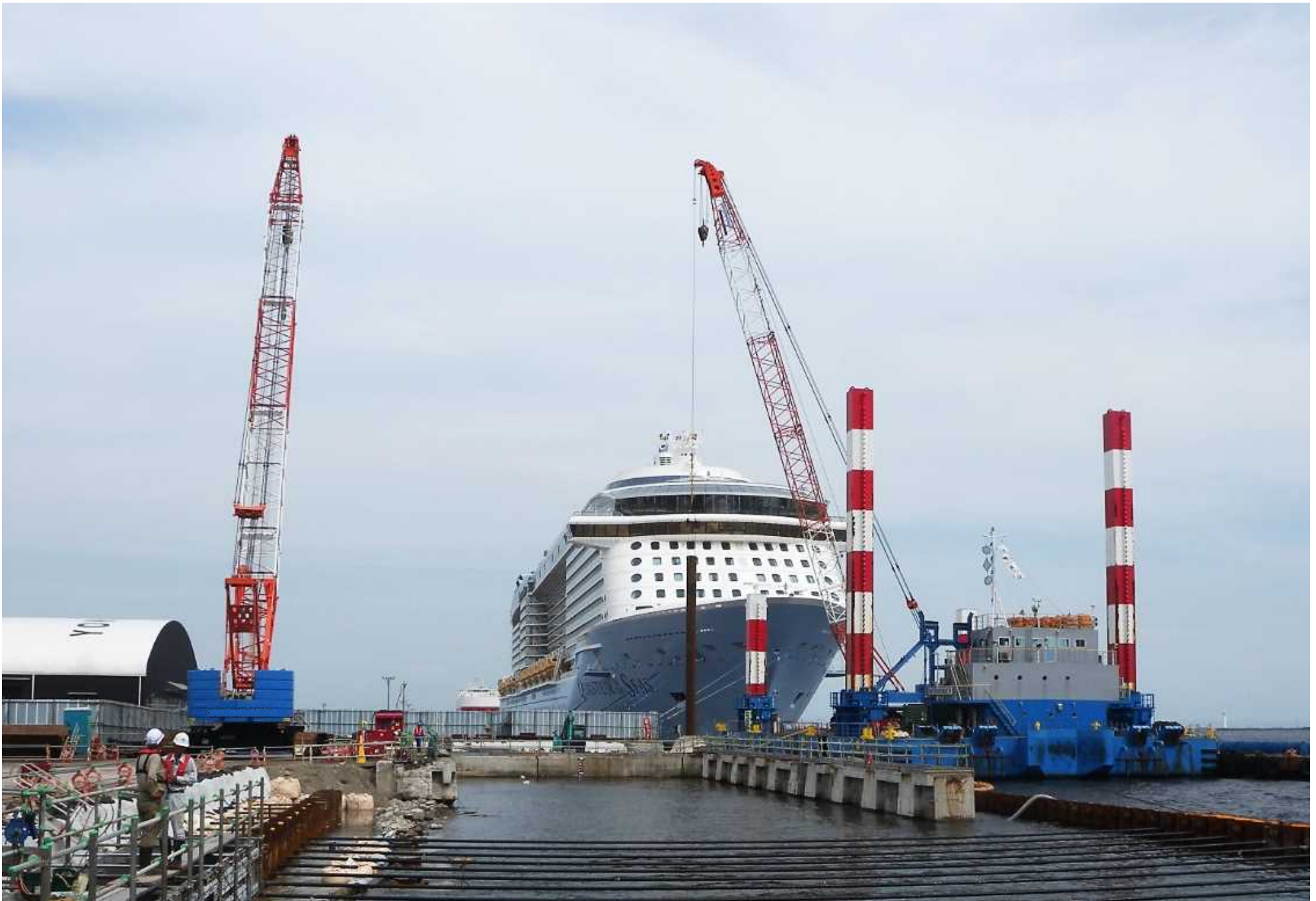
大黒埠頭岸壁上部工事とクルーズ船「Quantum of the Seas」【京浜港湾事務所】
