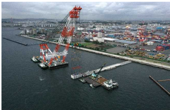
ケーソン据付施工状況
