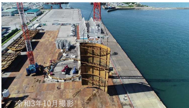
鋼板セル製作・組立状況
