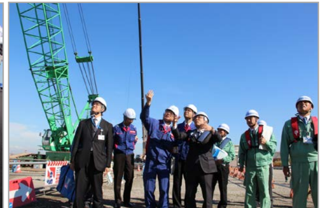
陸上部工事現場（ニューマチックポン）のご視察
