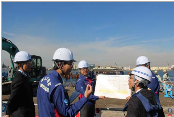
海上部工事現場（鋼管矢板井筒基礎）のご視察
