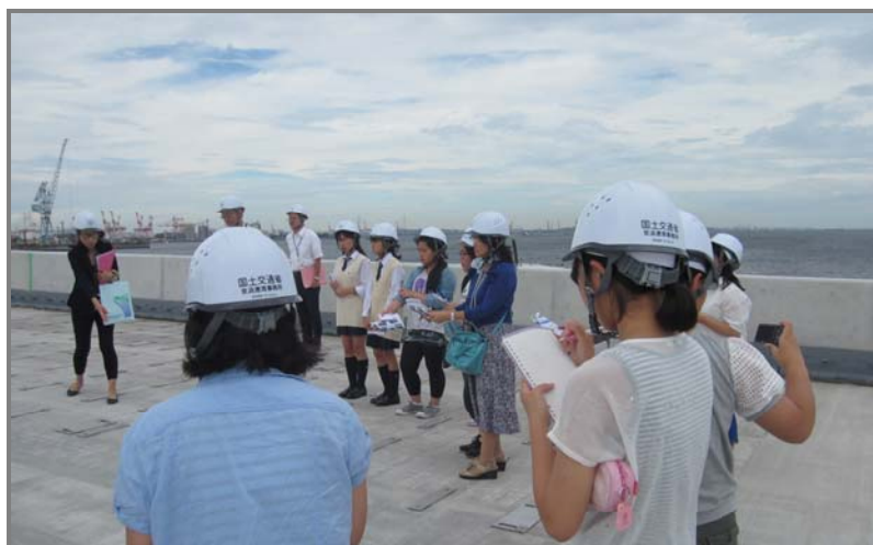
横浜臨港道路工事現場の視察
