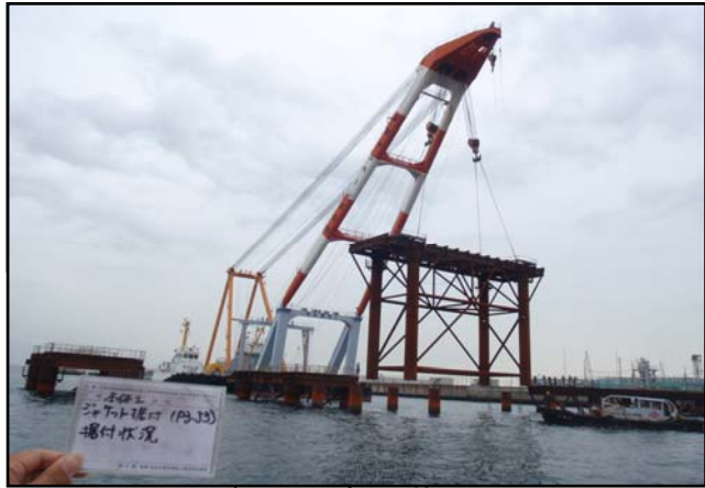
ジャケット据付状況
