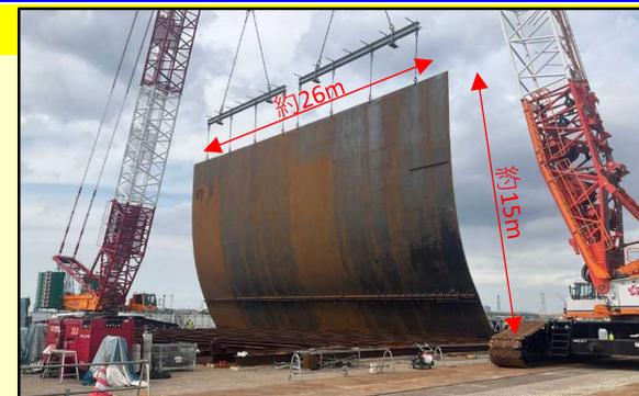
鋼板にパーツを溶接した後は、反対の面にひっくり返して、裏面の溶接作業を進めていきます。この鋼板は1枚約26m×15mの大きさがあり、最終的にはこれを5枚溶接して筒状にします。
