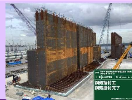
鋼殻完成後、高さ約20mの鋼殻の上からコンクリートを打設するよ。
