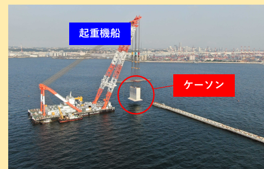
基礎工事 本体工事(設置) 裏込工事
